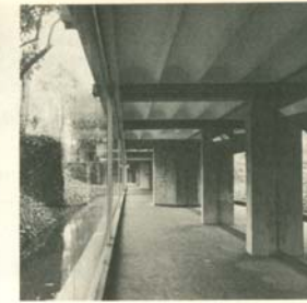
Corredor vestibulo Corredor vestibulo
